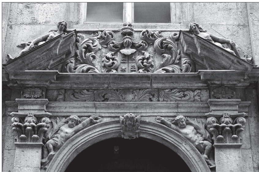
6. att. Dannenšterna nama portāls. 1696.–1699. g. Mārstaļu iela 21
